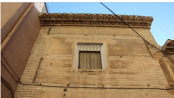
Figure 15. Building on calle Monjas no. 54 (residence within the Real Monasterio de la Encarnación) (Source: authors).
