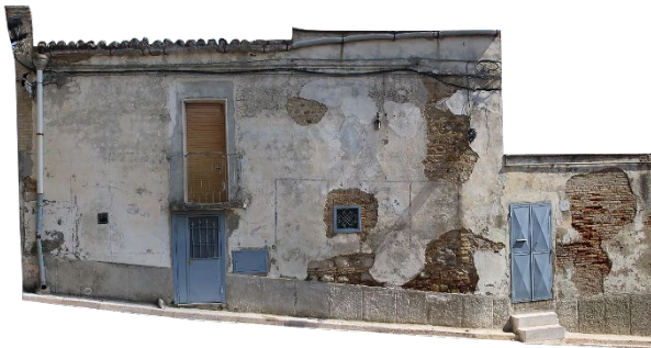
Figure 4. Orthoimage of wall of testing building n.1 (TB1)
